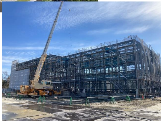
建設工事の様子 (2022年12月現在)
